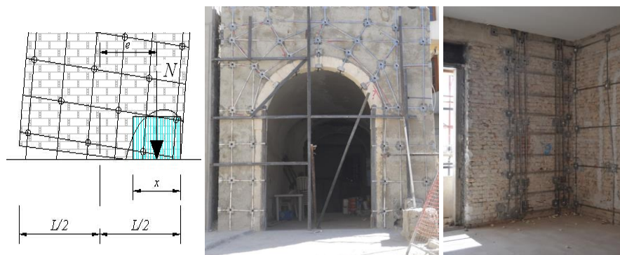
Figura 20. Schema di calcolo e applicazione del rinforzo CAM® a pressoflessione
