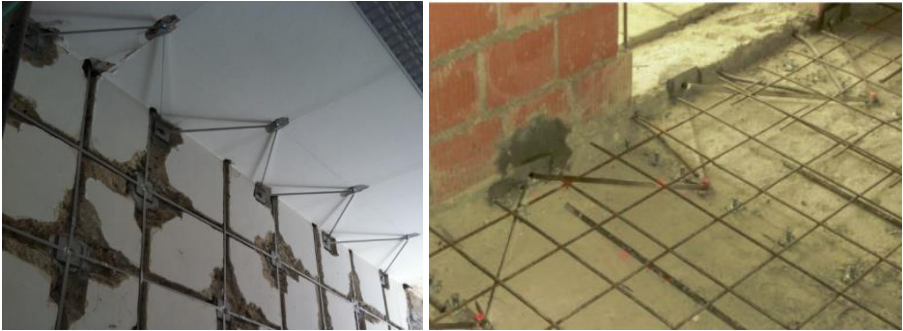
Figura 10. Intervento CAM® di arpionatura dei travetti di solaio
