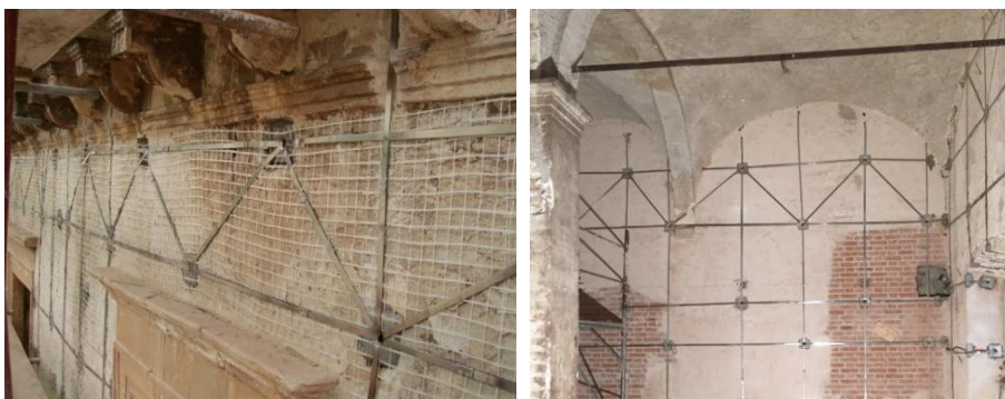
Figura 9. Realizzazione di cordoli in corrispondenza del solaio
