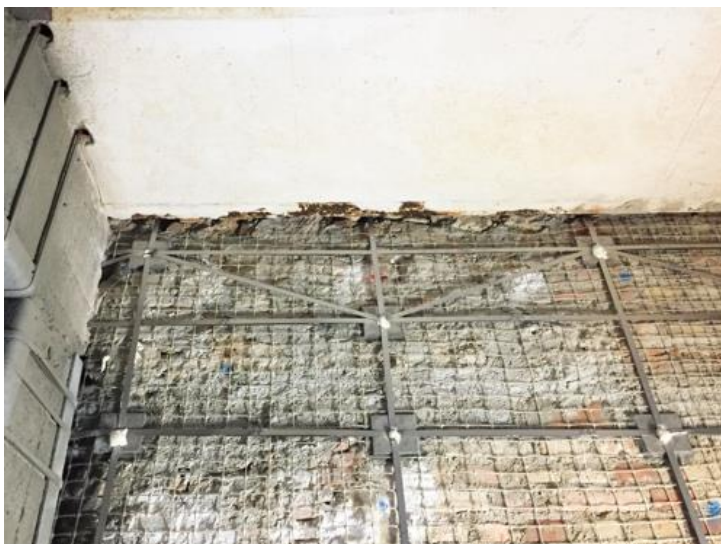
Figura 7. Esempio di applicazione della maglia CAM® in abbinamento alla rete in matrice polimerica
